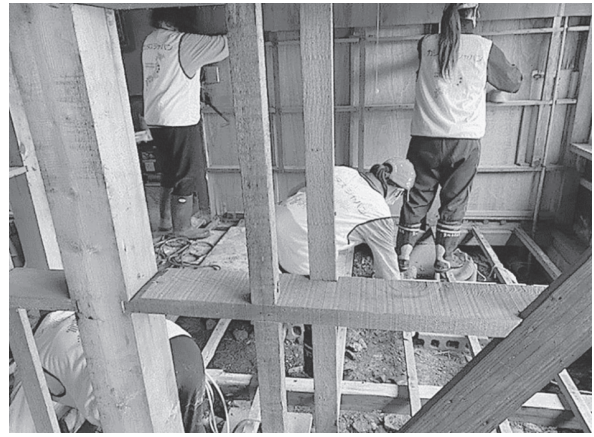
本学学生や他団体ボランティアと民家の床板、壁板の撤去、床下の泥だし作業中
